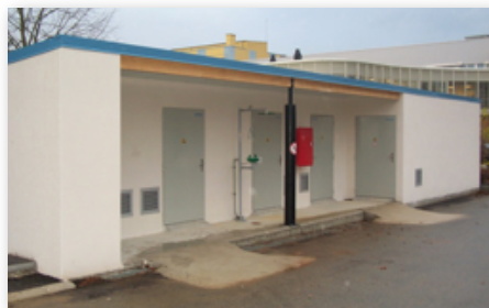
Local stockage produits chimiques INRA Nantes
