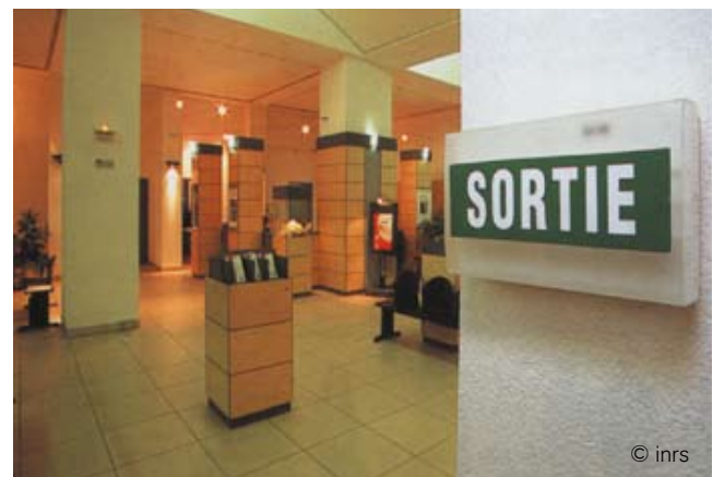
Il permet la visualisation des cheminements et des issues de secours. Ce sont des blocs luminueux d'ambiance ou de signalisation.
